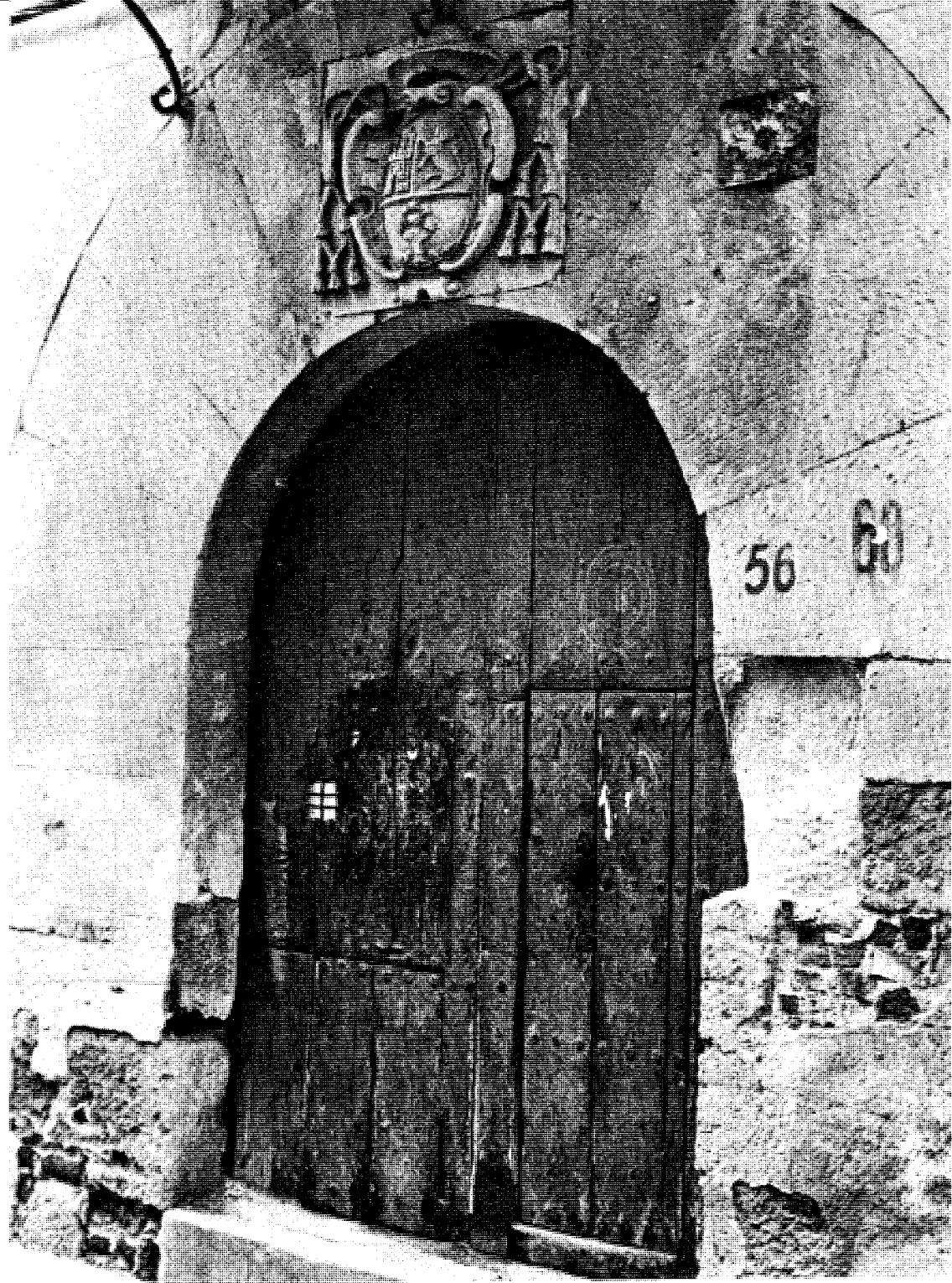
Puerta del Colegio de los Angeles. Salamanca.
